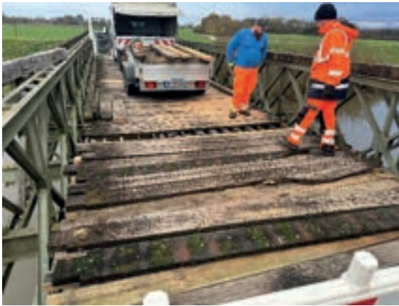
Sanierung Holzbelag an der Baileys-Brücke
