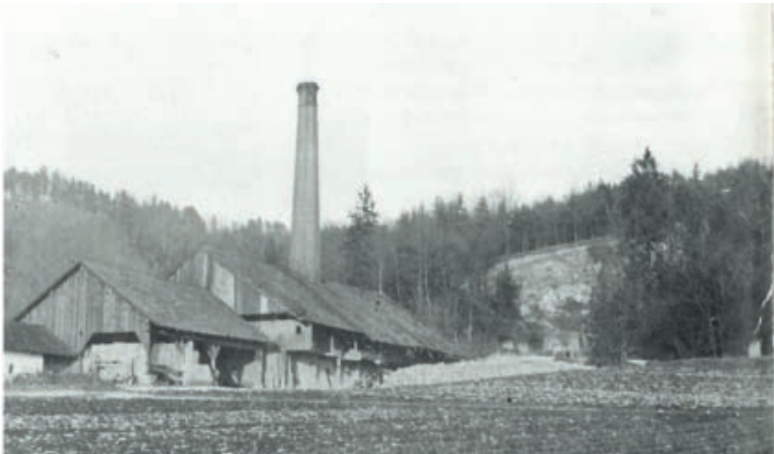
Foto aus dem Ziegel- und Kalk Museumsführer: Ringofen und Steinbruch. Rechts neben dem Ringofen lagert abgebrochenes Kalkgestein, unter dem Vordach des Ringofens sind gebrannte Ziegel gestapelt. Aufnahme um 1924.
