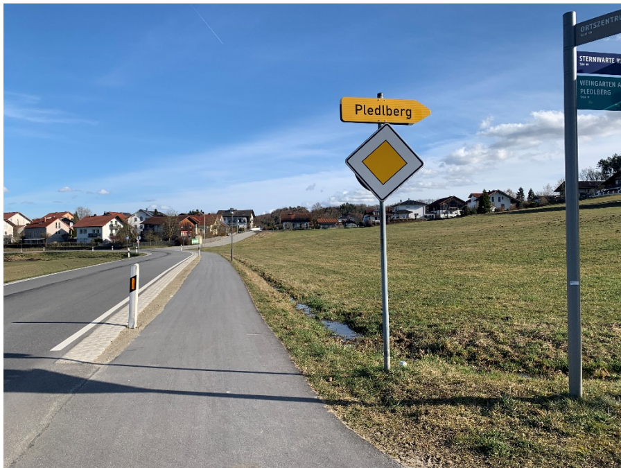
Abb. 2: Ansicht von Westen – Schwanenkirchner Straße mit Gehweg und Entwässerungsgraben, Foto Jocham + Kellhuber (Februar 2022)
