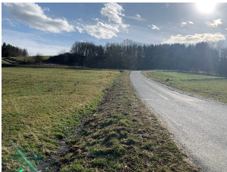
Abb. 4: Ansicht von Norden – Entwässerungsgraben entlang Pledlberg, Foto Jocham + Kellhuber (Februar 2022)
